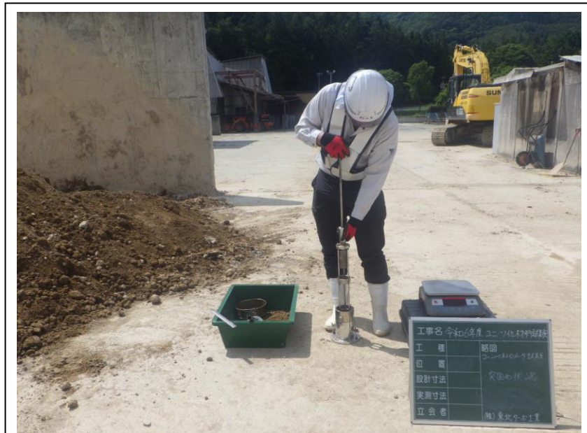
供試体突固め状況
